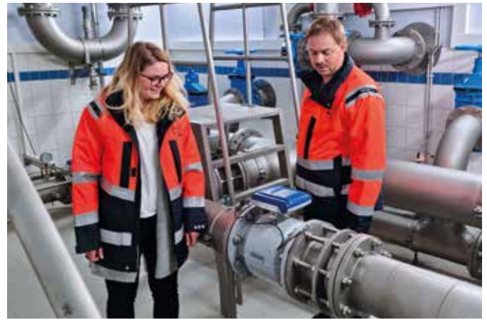
Inaugenscheinnahme der neuen Verrohrung durch Elisabeth Ziegler und Daniel Hofmann
