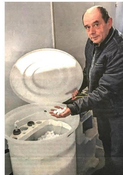
Der Juragruppen-Geschäftsführer Hans Hümmer in der mobilen Wasserreinigungsanlage mit Siedesalz und Elektrolyse, ohne Rückstände wie bei der Chlorbleiche (Foto: Frank Heidler)
